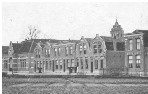
Jan Kortlandstraat 11 en 13, gebouwd in 1899 en door de ontwikkelaars verkocht aan goud- en zilverfabrikant G.J. Niekerk die nr. 13 met achtergelegen werkplaats (twee-onder-één-kap met de werkplaats van nr. 11) verhuurde aan de zilversmidsfamilie J.C. Wewer. Zoon C.F. Wewer kocht het pand in 1920. Zilversmid Wilhelmus Brehm kocht het pand en werkplaats in 30. Gemeentelijk Monument.
