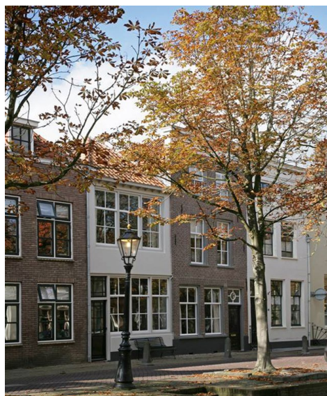
Oude Haven 28-30, goud- en zilversmidswerkplaats over twee verdiepingen met naastgelegen woning. Woning en werkplaats zijn inpandig geïntegreerd. Woonhuis uit 17de eeuw met schilddak en rechte kroonlijst uit de 19de eeuw. Werkplaats verbouwd tot zilversmidswerkplaats in 1863, welke als zodanig dienst deed tot 1990. Het ensemble is Rijksmonument.
