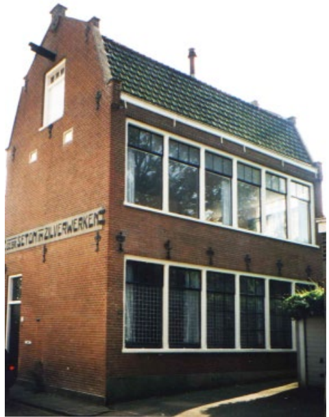
Zilverfabriek Korte Weistraat 12, gebouwd door Gerrit Greup Dhz in 1907. Rijksmonument.
