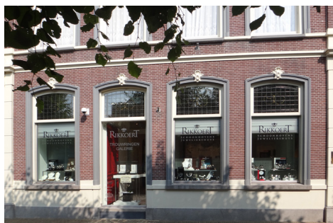
Haven 7, exterieur, begane grond met entree, hergebruikt als 'Trouwringen Galerie'. Foto 2011 RKa.
