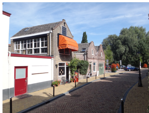
Varkensmarkt 4 waar anno 2011 'Hemels Goud' gevestigd is; goudsmidatelier met winkel en werkplaats op de verdieping. Het onderste grote raam uit 1871 is later dichtgezet door de aanbouw van Lopikerstraat 40, nu keuken van Chinees restaurant 'Peking'. Foto 2011.
