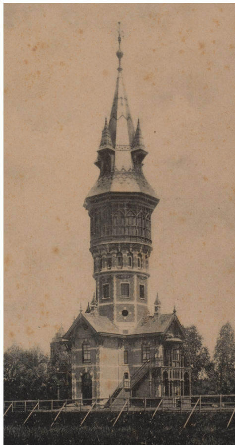
Watertoren Schoonhoven omstreeks 1903 met entree van de machinistenwoning. Foto Collectie Van Holten.
